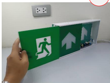
ประกอบแผ่นป้ายเข้ากับตัวเครื่อง ทั้งสองด้าน
