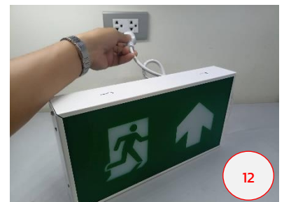
เสียบปลั๊กไฟตัวเครื่องเข้ากับเต้ารับ 220 โวลต์
