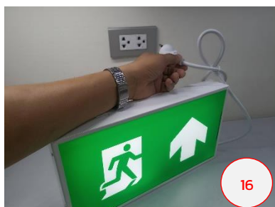
ดึงปลั๊กไฟตัวเครื่องออก แสงสว่าง ของป้ายจะต้องสว่างอย่างต่อเนื่อง
