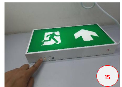
กดสวิทช์ "Test" ที่ตัวเครื่องหรือ รีโมทเพื่อทดสอบการทำงาน เบื้องต้น แสงสว่างของป้ายจะต้อง สว่างอย่างต่อเนื่อง
