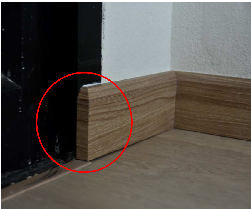
นำชิ้นบัวผนังอีกชิ้นที่จะใช้ปิดขอบ นำมาวัดและตัด จากความหนาของบัวผนัง และติดด้วยกาวร้อน
