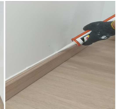
ใช้กาวยางและกาวร้อนในการยึดติดบัวผนัง ใช้อะคิลิคแดงในการยาแนวเก็บความสวยงาม
