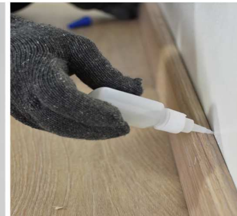
ใช้กาวยางและกาวร้อนในการยึดติดบัวผนัง ใช้อะคิลิคแดงในการยาแนวเก็บความสวยงาม
