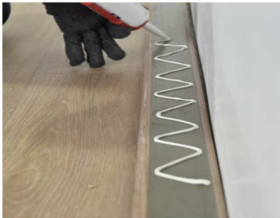
ใช้กาวยางและกาวร้อนในการยึดติดบัวผนัง ใช้อะคิลิคแดงในการยาแนวเก็บความสวยงาม
