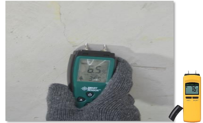
การตรวจสอบความชื้น (ความชื้นไม่เกิน 15%)
