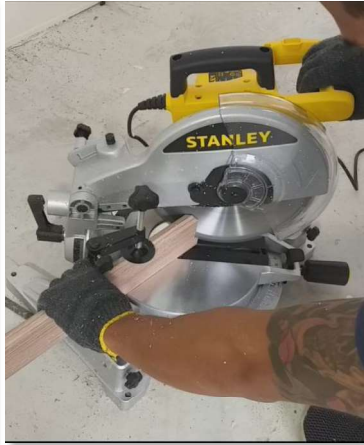
ตัดด้วยเครื่องตัดไฟฟ้า และลองประกอบเข้ามุม
