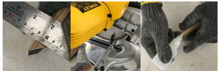
นำชิ้นบัวผนังอีกชิ้นที่จะใช้ปิดขอบ นำมาวัดและตัด จากความหนาของบัวผนัง และติดด้วยกาวร้อน
