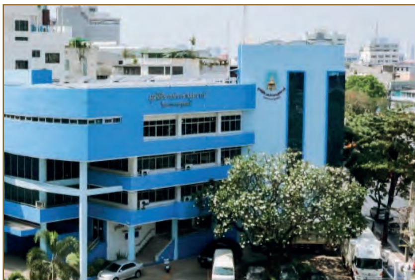
อาคารที่ทำการมูลนิธิราชประชานุเคราะห์ฯ ตั้งอยู่ถนนกรุงเกษม เขตป้อมปราบศัตรูพ่าย กรุงเทพมหานคร
